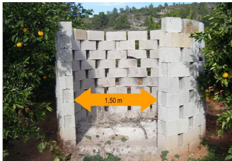
Abertura lateral o boca de alimentación de un quemador agrícola.
